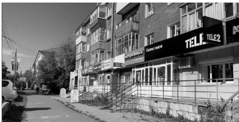
Неаккуратные фасады, вывески и крыльца
